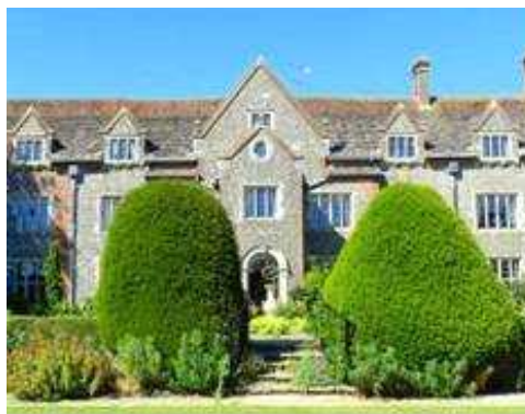
Ecclesden Manor (built c. 1630)
